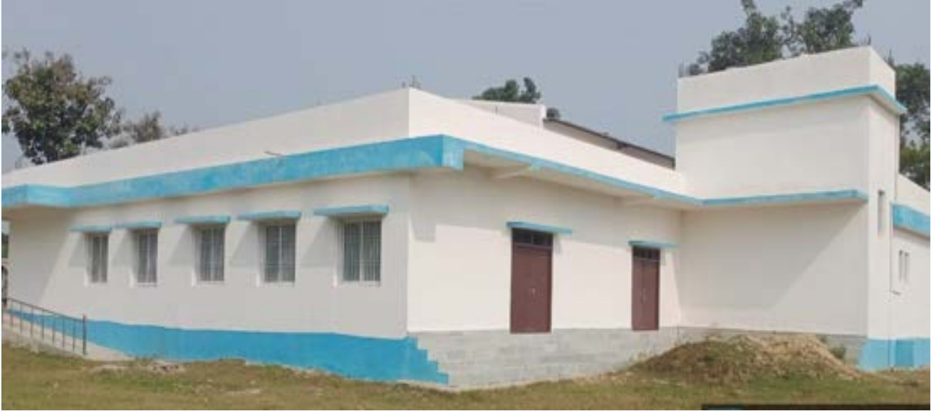
हरलाखी, ब्लॉक- हरलाखी, जिला- मधुबनी (बिहार) में इनडोर स्टेडियम/ऑडिटोरियम का निर्माण।
